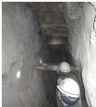
Рисунок 4. Рабочие и предохранительные полки из дерева
